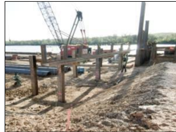
CSO 019 H-Pile Foundation & Cofferdam
